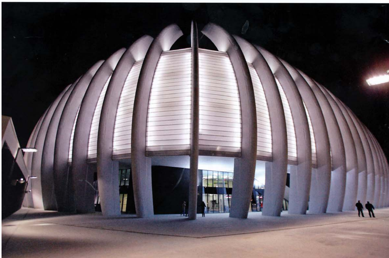
Die Multifunktionshalle Arena Zagreb wurde anlässlich der Handball-Weltmeisterschaft der Herren 2009 erbaut. Architekten: UPI-2M
