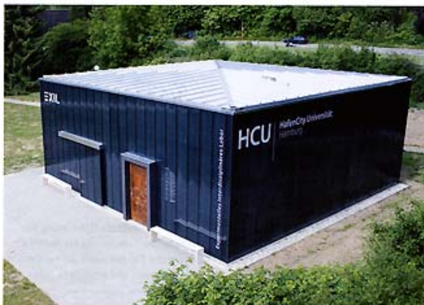
Fertiges Gebäude © HafenCity Universität Hamburg
