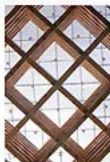
Dachmitte © HafenCity Universität Hamburg
